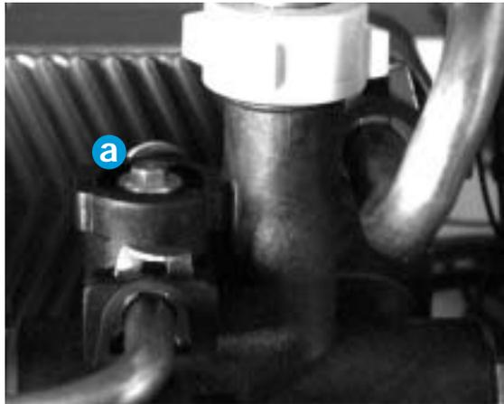
**Regolazione della portata del circuito riscaldamento**
