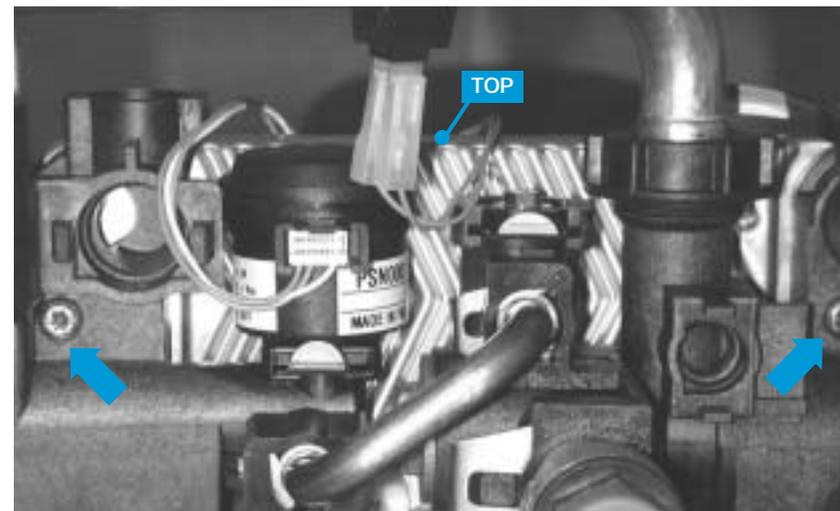
**Smontaggio motore della valvola deviatrice** togliere la clip **(1)** e ruotare per estrarre il motore.
